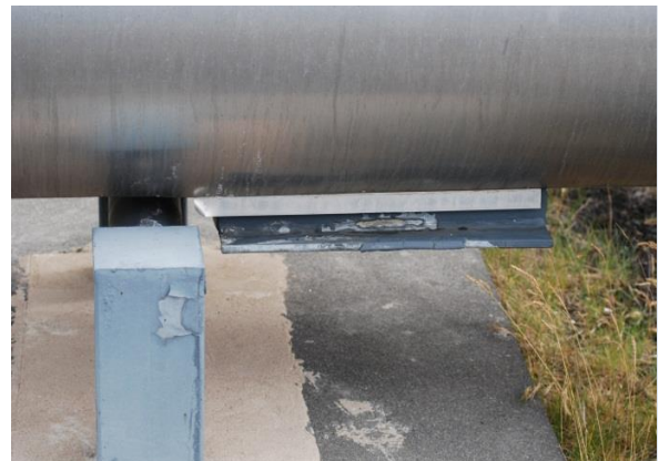
Mynd 8.7 Lögn sem svipt hefur af undirstöðu.
